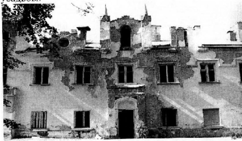
Дворовый фасад западного флигеля до реставрации 06.09.1997 года
